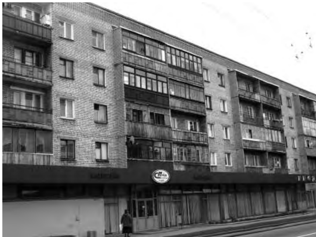
Hyreskasern i Grodno
